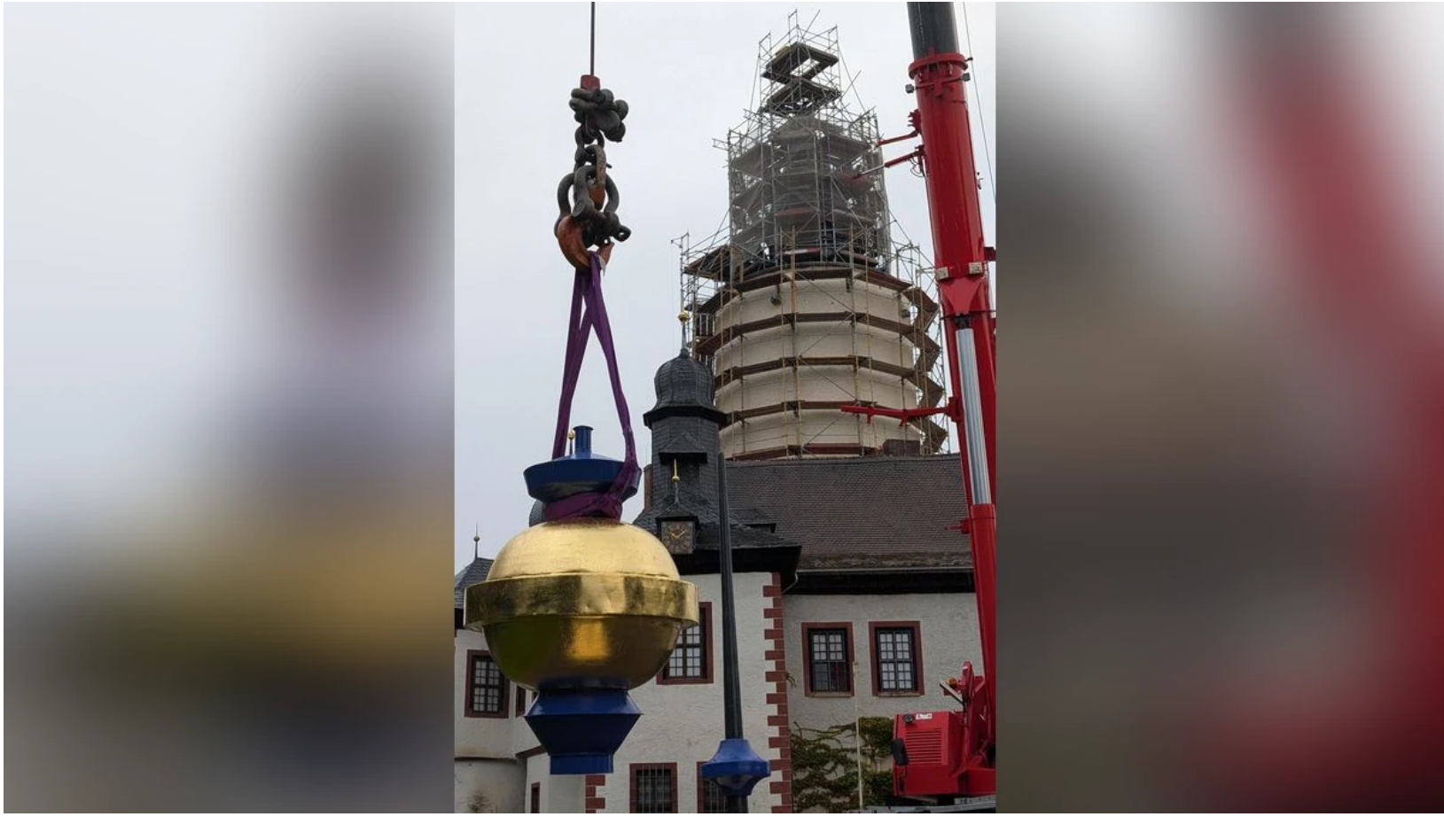
Der erste Höhenmeter ist geschafft. Jetzt geht es hoch hinaus.
